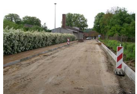
während der Bauausführung
